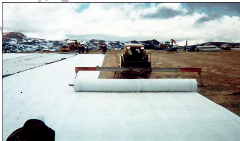
شکل ۵: مسلح سازی خاکریز با قرار دادن لایه ای از الیاف مصنوعی در بستر آن
