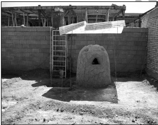
شکل ۷- شمای کلی کوره با پوشش بیرونی کاه‌گل.
