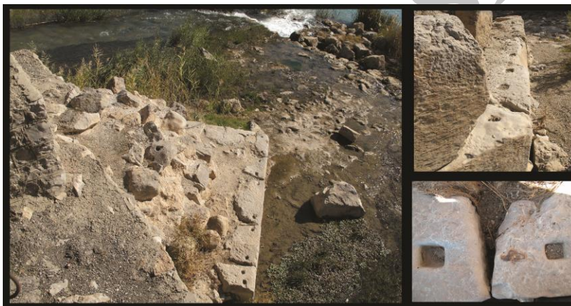
تصویر ۲۳: آبشکن‌های مثلثی و بستهای فلزی به کار رفته در ساختار پایه‌های پل خسرو (عکس‌ها از: مژگان خان‌مرادی).
