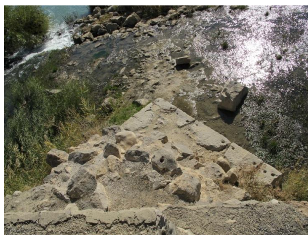
تصویر ۶: نمونه‌ای از آبشکن پل خسرو (عکس از نگارنده).
