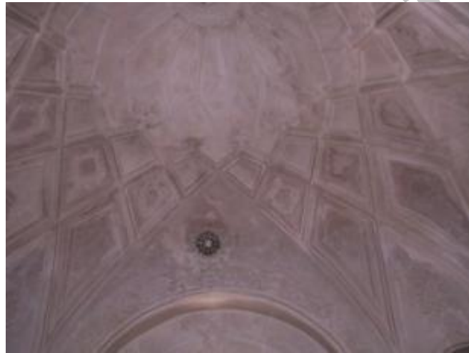
تصویر ۲۴: نمایی از کاربندی زیر گنبد قصر عمارت خسروآباد (عکس از نگارنده، ۱۳۸۸).
