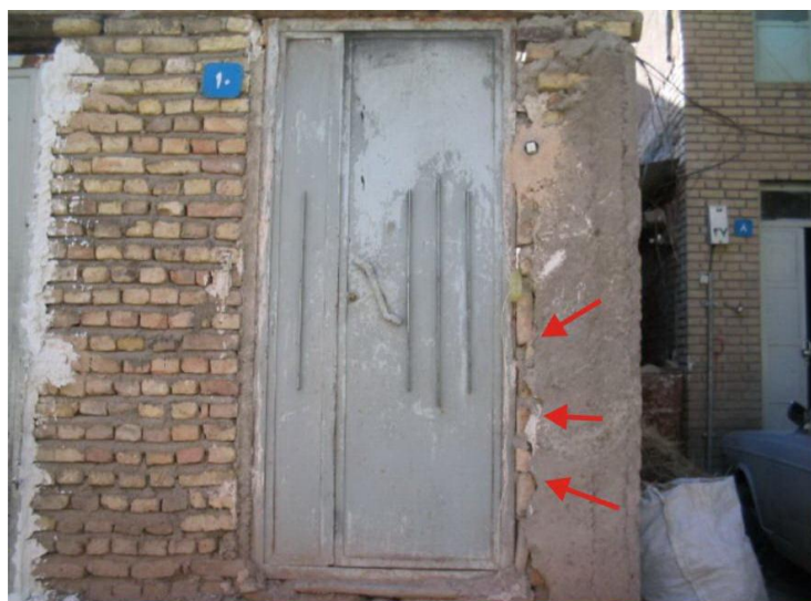
شکل 11: نمایی از یک خانه جدید که با توجه به نوع مصالح ساختمانی به کار رفته در ساختن آن، بر اساس مقیاس MSK در رده B قرار گرفته است. در این تصویر آثار تخریبی زمین لرزه فیروز آباد - کجور به نمایش در آمده است.
