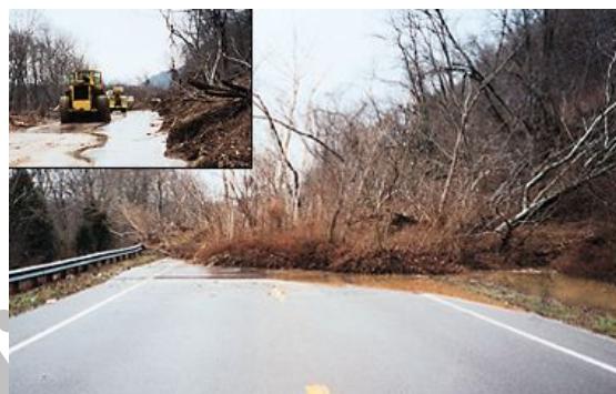
شکل ۷: نمایی از انسداد راه های ارتباطی بر اثر لغزش زمین
