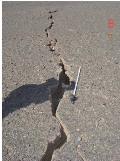
شکل (۱۱): نمونه‌هایی از شکستگی‌های برداشت شده مربوط به گسیختگی سطحی جدید در جنوب بم، ایستگاه ۳۹ (الف) و ایستگاه ۵۶ (ب). بالای تصویر (ب) به سمت جنوب است. در این تصویر یک فروافتادگی، حدود ۵ سانتیمتر، در سمت چپ (شرق گسل) به خوبی قابل مشاهده است.
