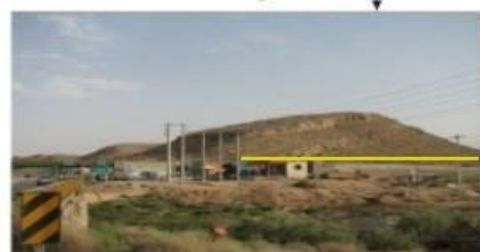
شکل (19) گسل پل فسا
