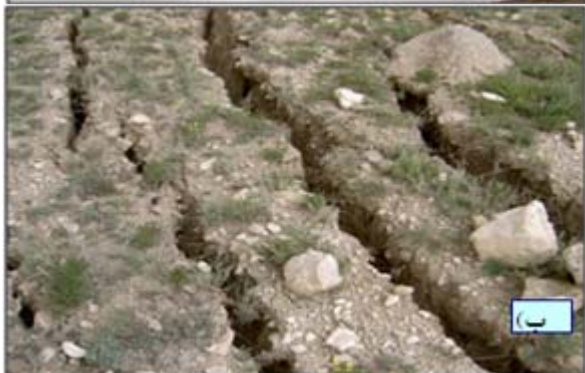
شکل (۸): الگوهای لغزشی در بخش های مختلف دیواره مخزن سد ماکو [۱۸]
