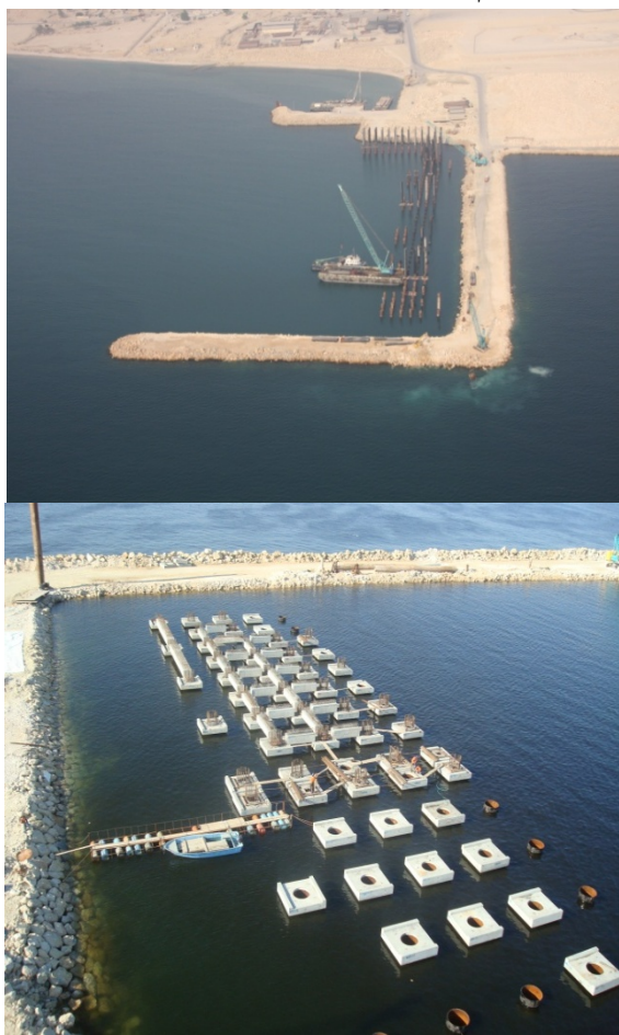
شکل (۱): مراحل ساخت پروژه LNG
