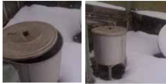
شکل ۳- اتلافات حرارتی منبع انبساط باز استوانه در فصل زمستان
