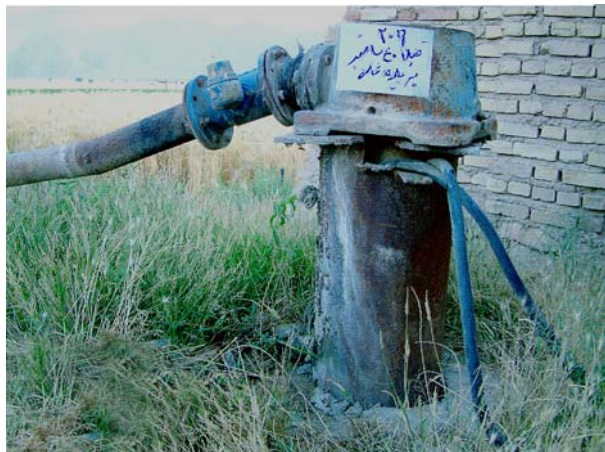
شکل ۵: فرونشست زمین در اطراف میله چاه عمیق در دشت قره بلاغ طی ۱۰ سال به اندازه ۱/۵۰ سانتیمتر بوده است. به دلیل بریدگی لوله آبرسانی متصل به پمپ از ارتفاع آن حدود ۴۰ سانتیمتر بریده شده و کوتاه شده است.
