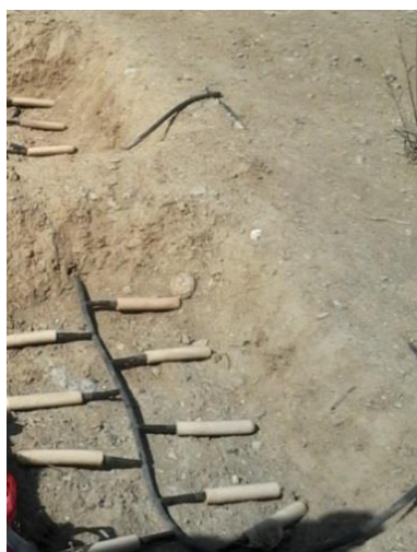
شکل ۱. نحوه اجرای سیستم آبیاری زیرسطحی به روش کیسول‌های رسی متخلخل
