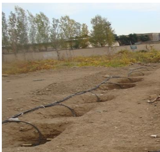
شکل ۱. نحوه اجرای سیستم آبیاری زیرسطحی به روش کیسول‌های رسی متخلخل
