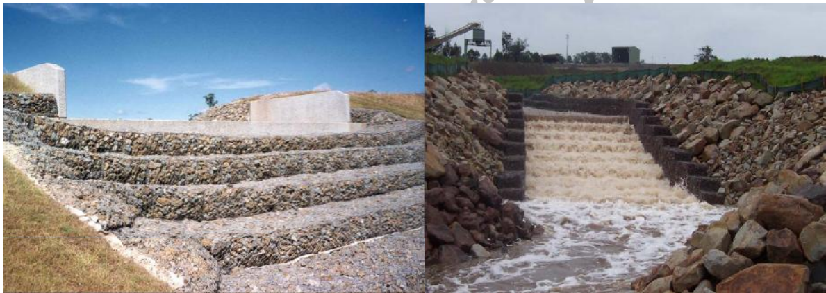
شکل 2: نمونه‌ای دیگر از سرریز پلکانی گابیونی
