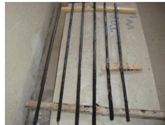
شکل ۵- مراحل ساخت میله‌های CFRP
