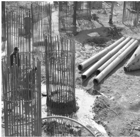
شکل ۲- پدیده انسداد ناشی از وجود میلگردهای حلقوی در بتن معمولی و جایگزینی آن با بتن خود متراکم
