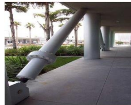
شکل ۲-ب-نمایی از میراگر نصب شده مرکز دارویی Arrowhead Regional Medical Center
