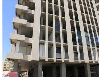
شکل ۱۵- اجرای پانل در نما [۱۲]
