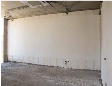
شکل ۱۳- اجرای پانل کامپوزیت به عنوان دیوار داخلی [۱۲]
