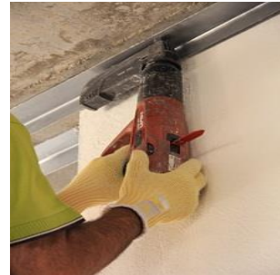
شکل ۱۶- نحوه مهار پانل به سقف [۱۲]
