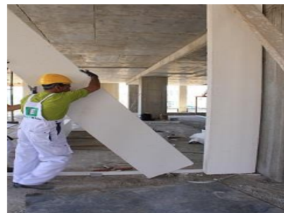
شکل ۱۲- نصب سریع در اجرای پانل‌ها [۱۲]
