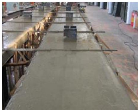
شکل ۴- تصویر تیر پس از بتن ریزی
