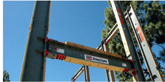
شکل ۲- نمونه ی اجرایی اتصال درختی سپری سیمپسون
