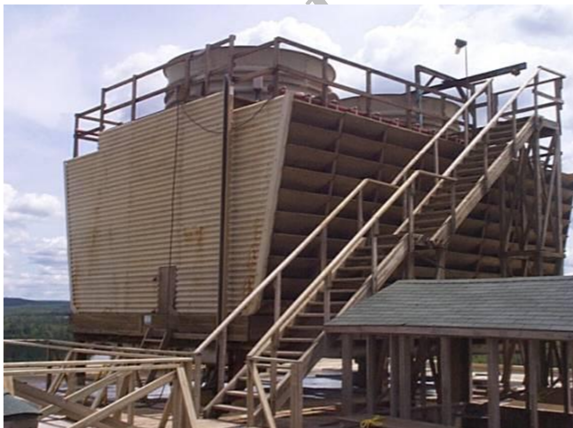
شکل ۴- برج خنک کننده با جریان عرضی
