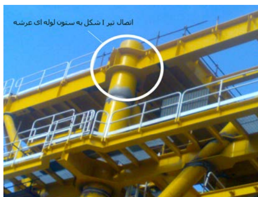
شکل ۱ - نمایی از کاربرد وسیع اتصالات تیر I شکل به ستون لوله‌ای در سکوهای نفتی [۱۶]
