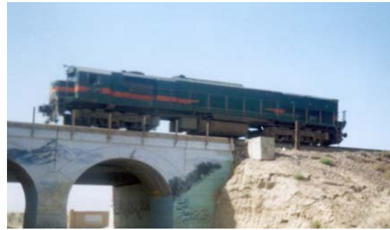
شکل ۱. دیزل ۱۲۰ تنی در ابتدای پل قوسی بتنی کیلومتر ۲۴ راه آهن تهران-قم
