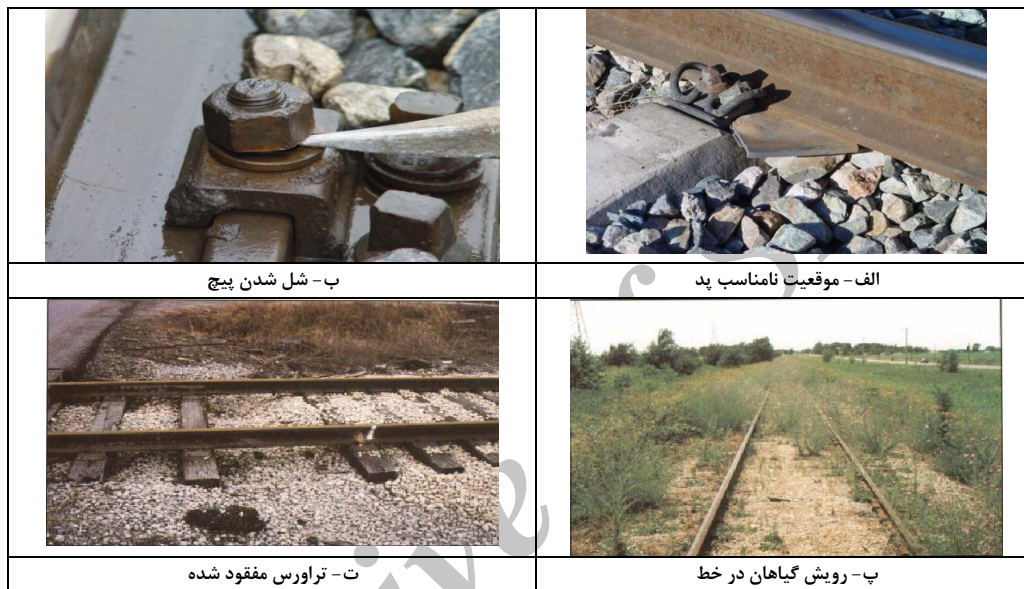
شکل ۱. نمونه ای از خرابی های خط در شبکه خطوط ریلی ایران
