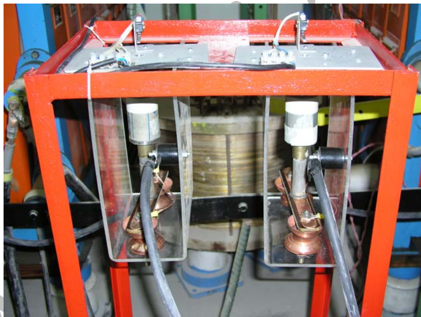
شکل (۹): نمایی از رله های H.V جدید
