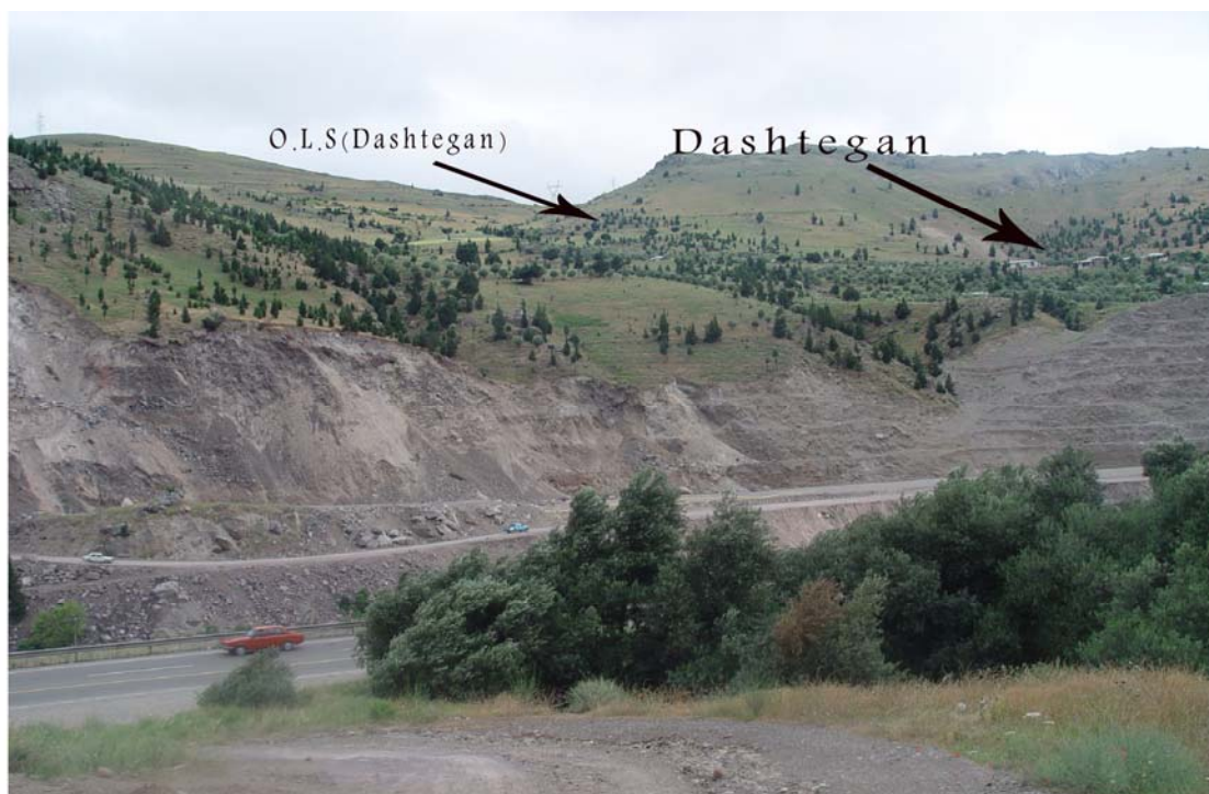
شکل ۴- کیلومتر ۲۹/۷۵ آزادراه، دید به سمت جنوب، برخورد توده زمین لغزش قدیمی دشتگان بر روی رسوبات پادگانه ای.
