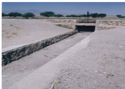
شکل ۱: وضعیت پوشش بتنی (سمت چپ) و سنگ وملات (سمت راست) در منطقه
