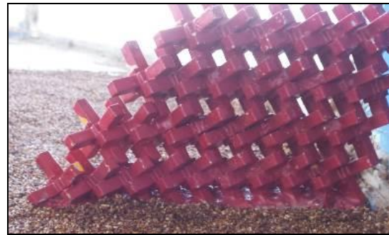
شکل ۴: نمایی از آبشکن هگزپاد نفوذپذیر متصل به ساحل
