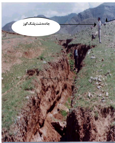
شکل ۵: پیدایش خندق تیپیک در امتداد جاده به واسطه‌ی کوچک شدن سطح آستانه تمرکز رواناب‌ها
