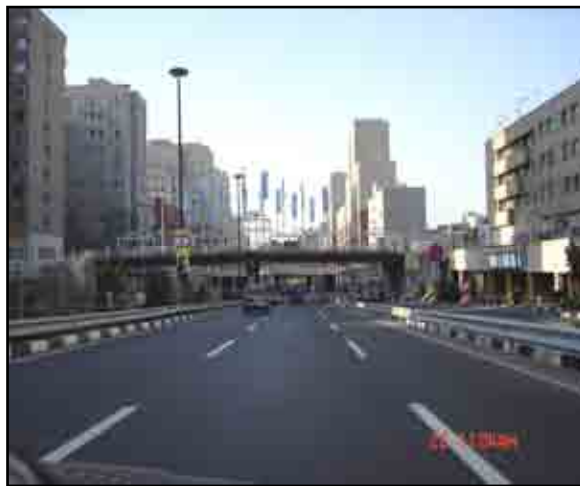
تصویر ۱: نمای بزرگراه نواب در مرکز شهر تهران مأخذ: نویسنده، تاریخ عکسبرداری، تابستان ۱۳۸۵
