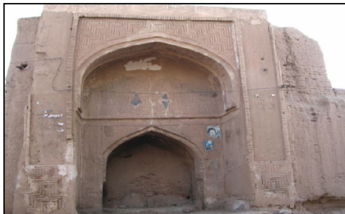
شکل ۷: آب انبار مسجد خطیب
