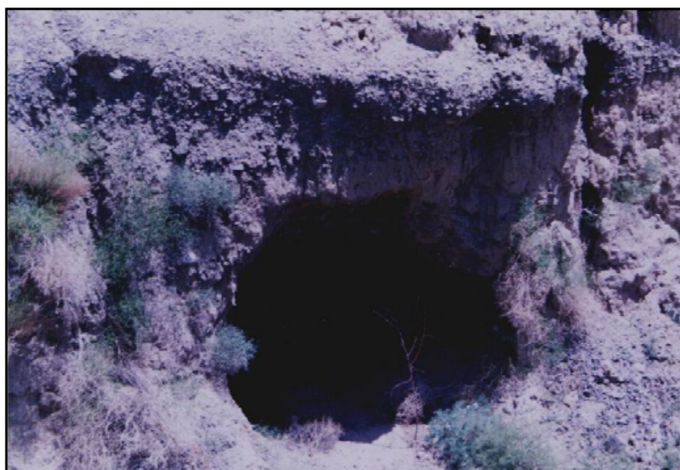
شکل ۸: فرسایش تونلی (Piping) در دیواره‌ی خندق دایمی موجود در حوضه
