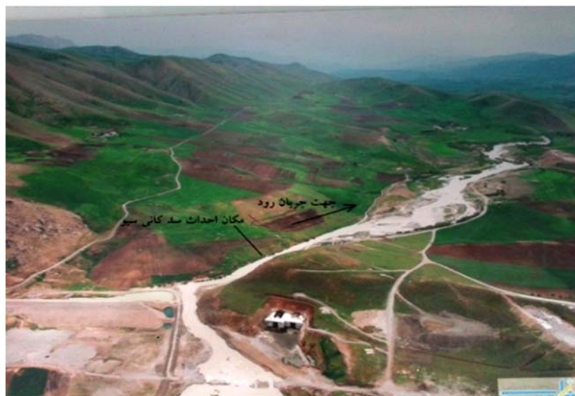
شکل ۸: مکان احداث سد کانی سیو بر روی رود زاب در ۱۳ کیلومتری جنوب پیرانشهر
