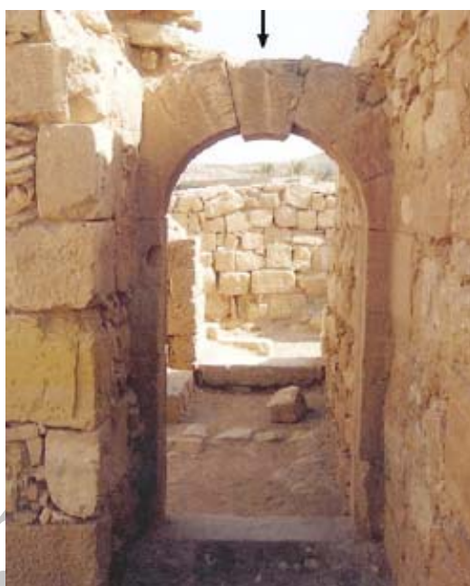
شکل ۹. سنگ سرتاق فرولغزیده در تاقی که به‌طور متقارن با دیوارها احاطه شده است (کامایی و هاتزور، در دست چاپ).
