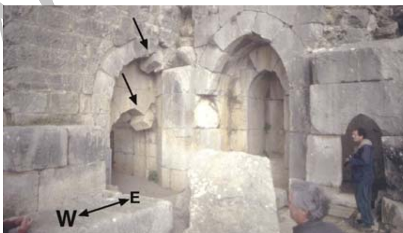
شکل ۱۰. بلوک‌ها در کناره تاق‌ها به سمت پایین لغزیده‌اند، کل ات نیمرد (Kal'at Nimrod)، کرانه خاوری مدیترانه (مارکو، ۲۰۰۸).
