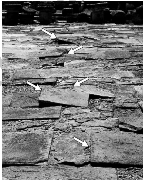
شکل ۸. بلوک‌های جابه‌جا شده در سنگفرش میدان بانلو کلودیا (Baello Claudia)، روم باستان، جنوب اسپانیا (سیلوا و همکاران، ۲۰۰۵).
