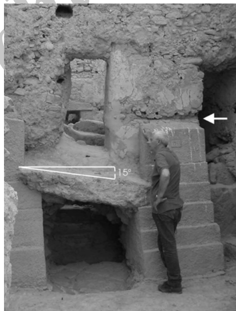
شکل ۱۱. واپیچش کف اتاقی در طبقه دوم کاخ فایستوس مینوآن (Phaistos Minoan)، کریت (Crete)، یونان (موناکو و ترتریسی، ۲۰۰۴).
