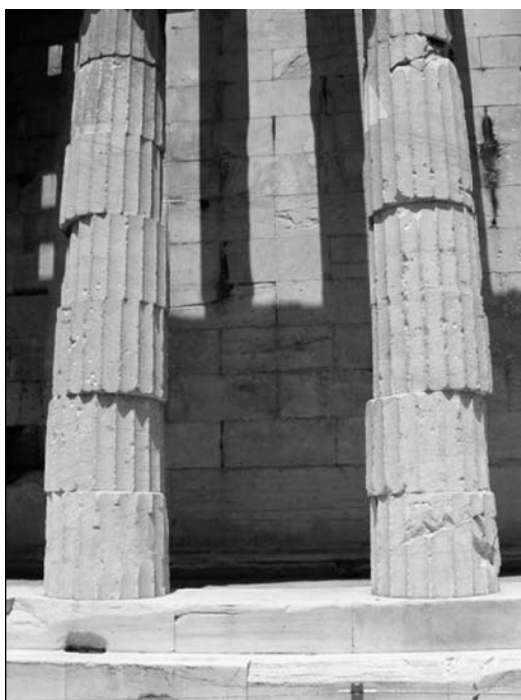
شکل ۱۲. چرخش و جابه‌جایی ستون‌ها حول محور قائم در هفایستیون (Hephaisteion) (تسیون (Theseion))، آتن، یونان (بوتاری، ۲۰۰۵).
