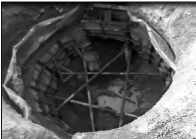
شکل ۷- مراحل ابتدایی بتن ریزی هاضم
