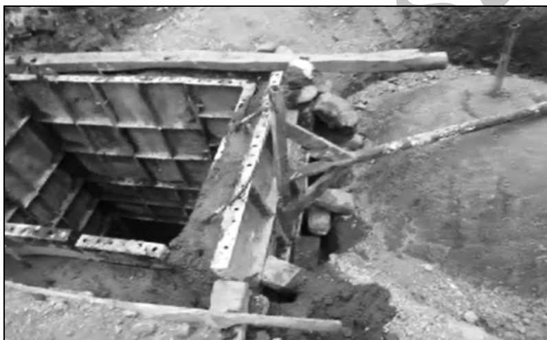
شکل ۸- مراحل آخر بتن ریزی هاضم
