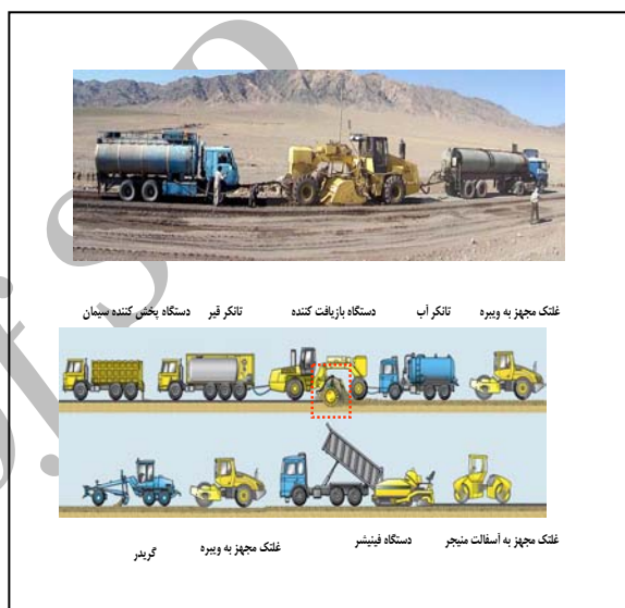
شکل ۱. نمایی از عملیات تثبیت خاک با قیر و سیمان
