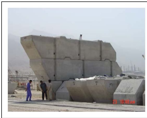
شکل ۲. تصویری از بلوکهای شیبدار در کارگاه ساخت قطعات پیش ساخته
