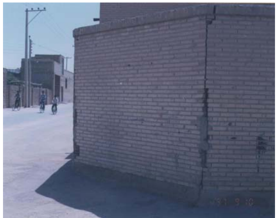
شکل 3. جابه‌جایی نسبی قسمتهای مختلف دیوار حیاط نسبت به هم و ایجاد گسیختگی در محلهای تمرکز تنش (شهرک امام جعفر صادق)
