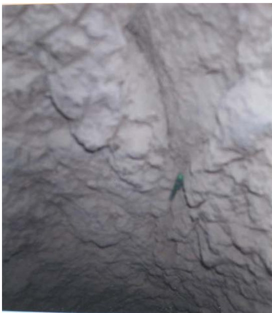
شکل 7. تصویر شکاف در عمق شش متری در گمانه دستی
