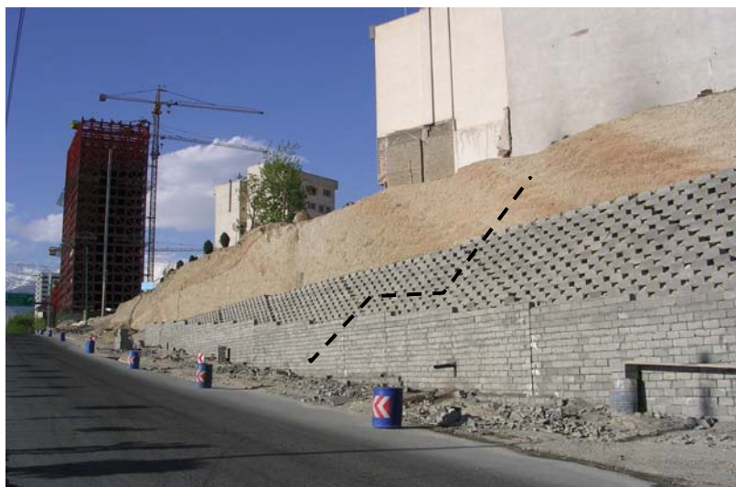
شکل 8- ب. دیوار حایل کنار خیابان برای پایدارسازی شیب و ایمن‌سازی ساختمانهای مسکونی بالای شیب
