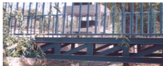
(ب) پل فلزی عابر پیاده در خیابان صائب در شهر اصفهان، تحریک شده توسط چکش ۲
