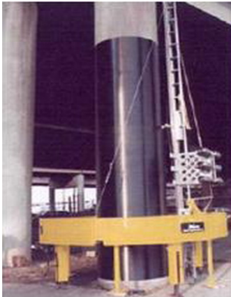
شکل ۱. نمونه‌ای از تقویت پایه پل بتن آرمه با صفحات FRP
