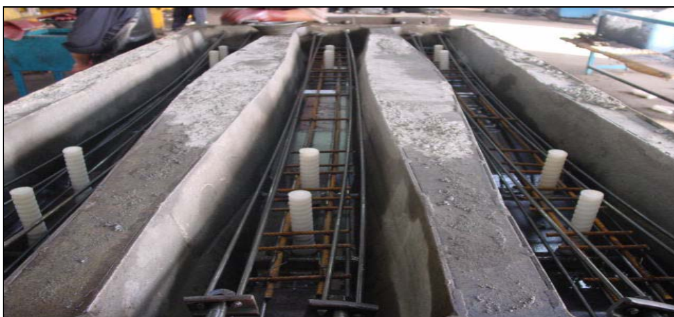
شکل ۱۱. تقویت تراورس با شبکه‌های آرماتور
