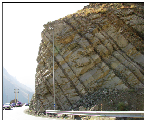
شکل ۸. شیروانی سنگی مشرف به جاده چالوس (دارای پتانسیل شکست واژگونی بلوکی - خمشی)
