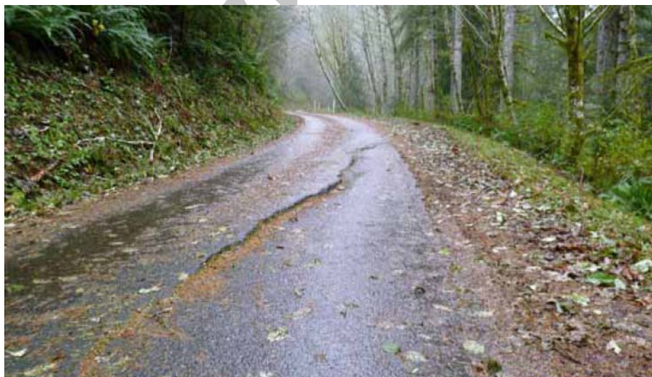
شکل ۱. ترک‌های ایجادشده بر روی جاده (Musser & Denning, 2005)
