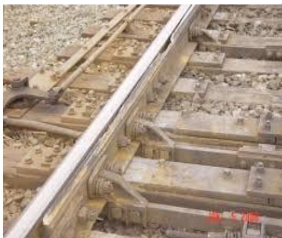
شکل 1. لب پریدگی تیغه سوزن
