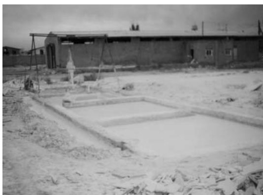
تصویر ۲- حوضچه های رسوبگیری در یک کارخانه با نگهداری ضعیف؛ پس از تبخیر و خشک شدن گل ها تخلیه و به محل دفع منتقل می شود.
