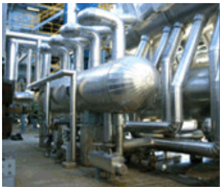
شکل ۶- مبدل خاص تولید بخار آب اشباع
