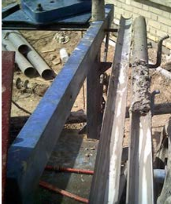
شکل ۶- خارج نمودن مغزه گیر از چاه و باز نمودن آن جهت عملیات بعدی.
