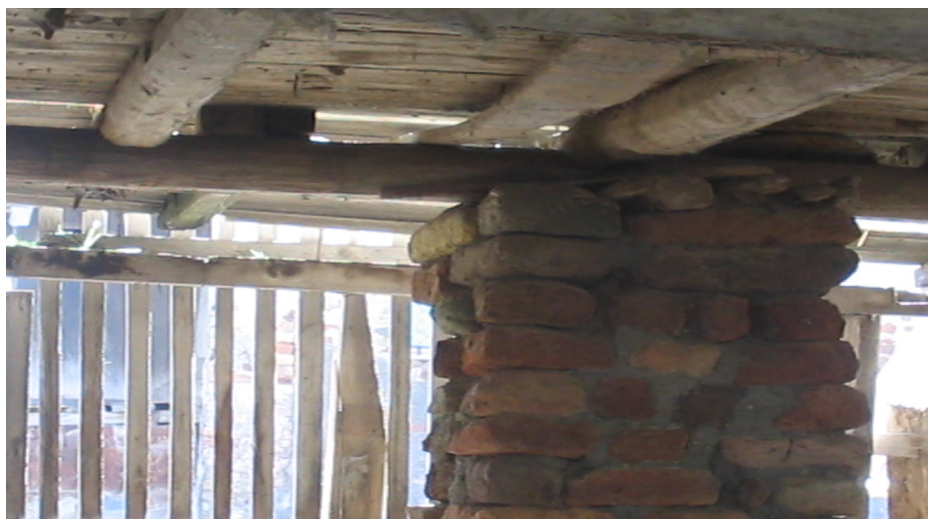
تصویر ۲- نحوه بنای خانه بر روی پایه ها
