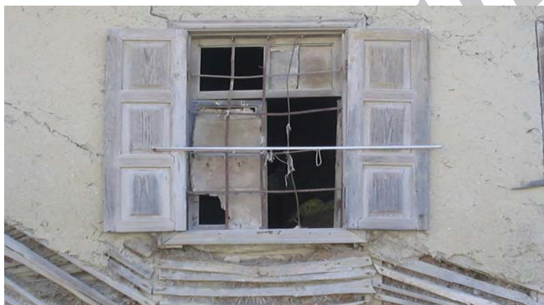
تصویر ۲- درب و پنجره های منازل قدیم گمیشان و نوع چیدمان الوار مورب در دیوار
